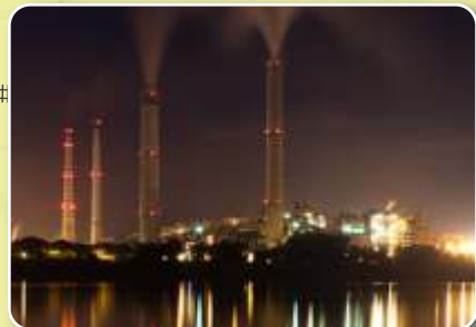
Kota Thermal Power Plant
